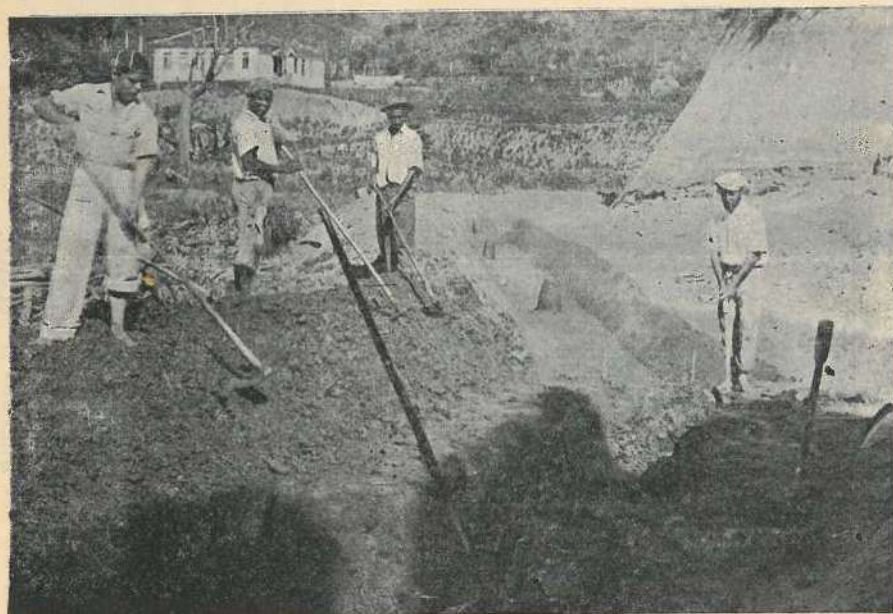
Fig. 2 — Construção do canal principal.
