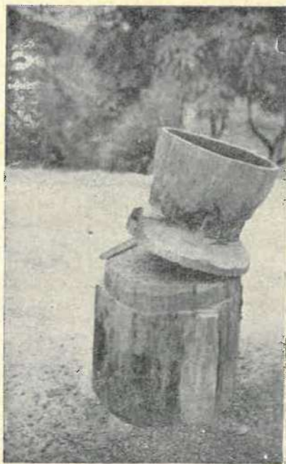
Fig. 4 — Moinho a mão, usado nas fazendas sem quedas d'água, para beneficiar café e milho, para gasto doméstico. Resplendor.
