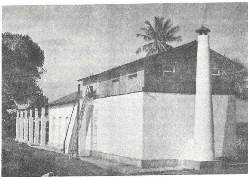
FIGURA 2 - Secador tubular. No primeiro plano, a chaminé e, por trás do secador, uma barcaça.
